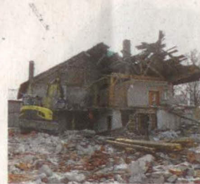
Baustelle im Überblick.
