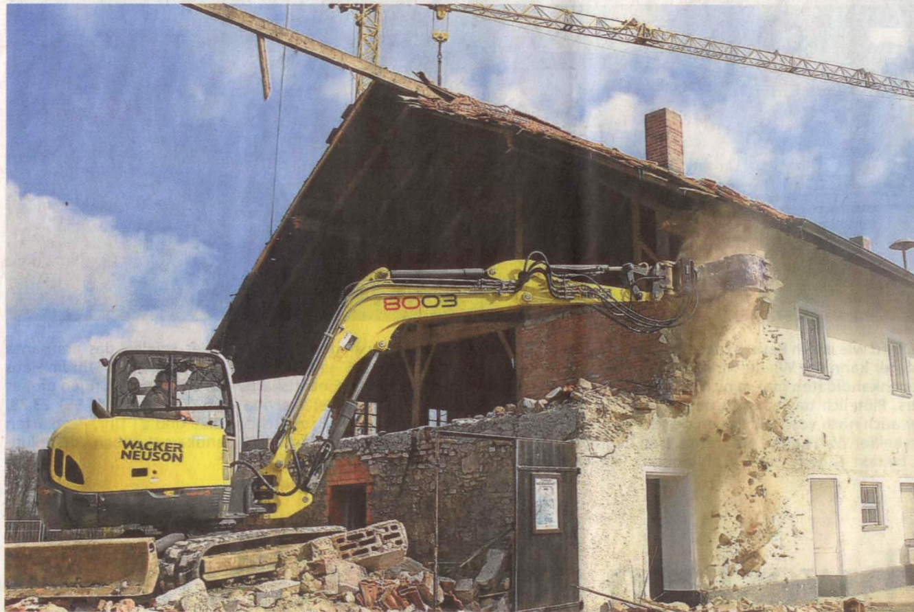
Hier stand einmal ein Schützenheim. Dieser Bagger reißt die Mauern bis auf den Boden ein.
